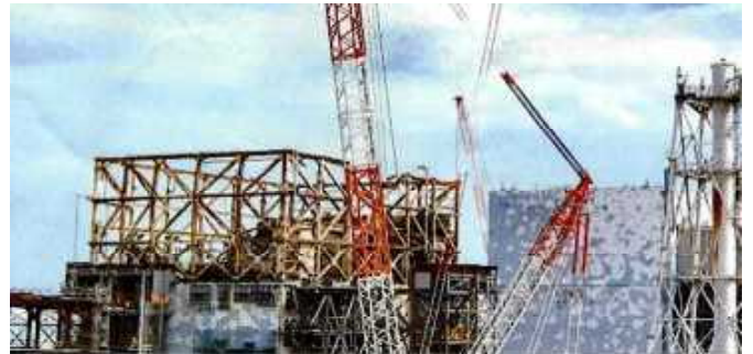
（資料11） 縦66 m 横56 m 高さ68 m で建屋全体を覆う計画
