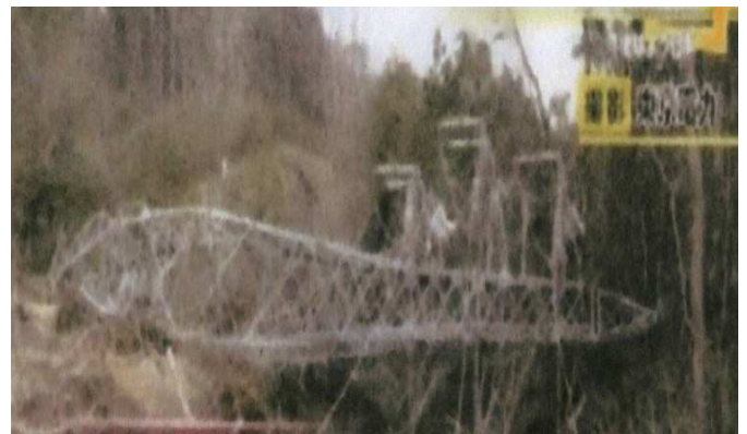
(資料2) 全電源喪失となった送電線倒壊現場
